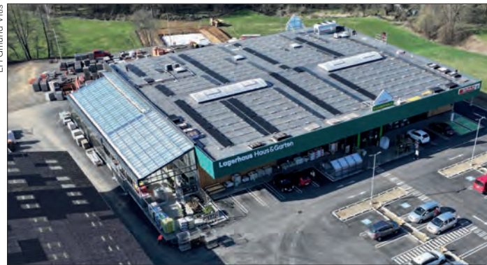
Der innovative Lagerhausmarkt verfügt unter anderem über eine Photovoltaikanlage mit einer Leistung von 220 kWp.
